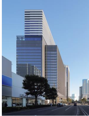
Yokohama Connect Square (Kanagawa Prefecture)
