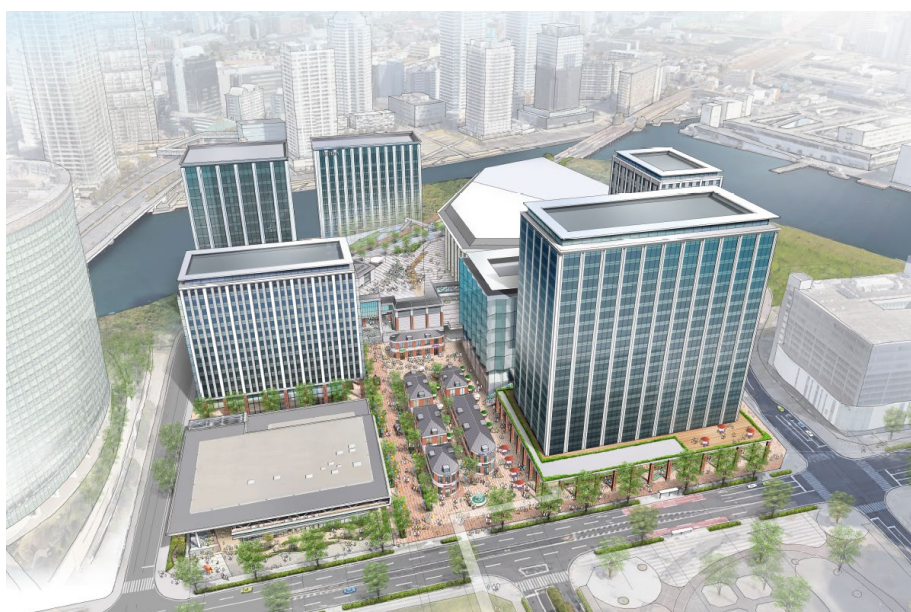
「みなとみらい 21 中央地区 60・61 街区」
