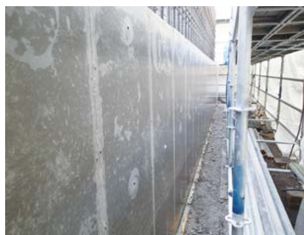
シートによる養生状況
