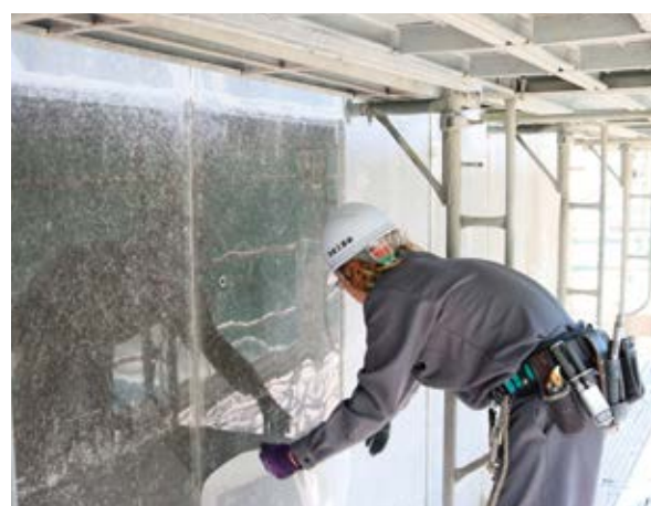
シート撤去作業状況
